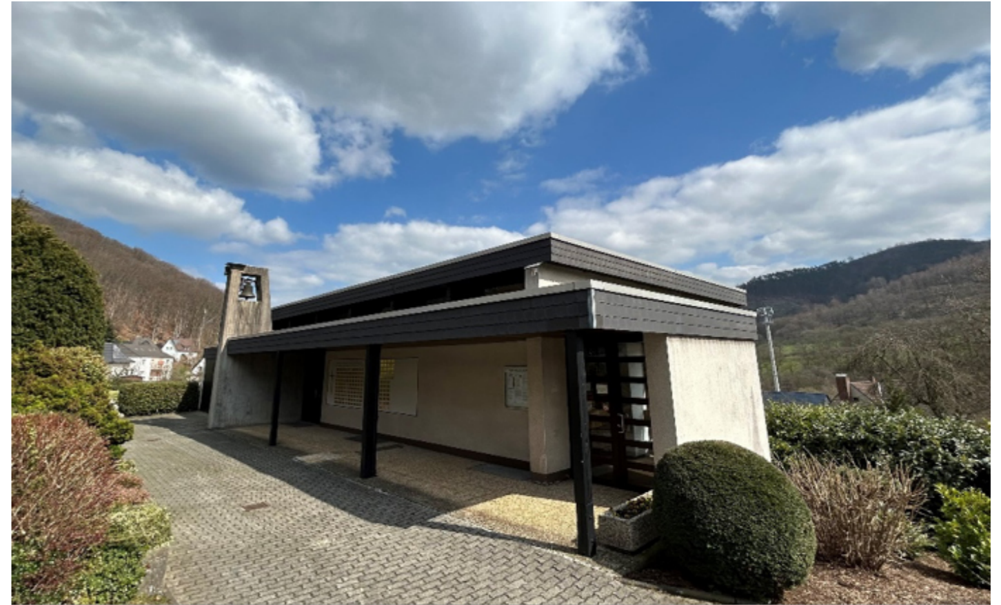
Die Michaelskapelle in Einsal – Durch eine grundlegende Renovierung und räumliche Umgestaltung sollen neben Trauergottesdiensten hier demnächst auch weitere liturgische Feiern und Gemeindeveranstaltungen möglich sein.
